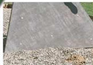
**Placas antideslizantes:** madera de contrachapado de abedul y pino, en este caso revestidas de una película lisa de 440gr/m2 en la cara contraria. El lateral está tratado con dos capas de pintura gliceroptálica sin plomo, de gran resistencia y alta protección.
