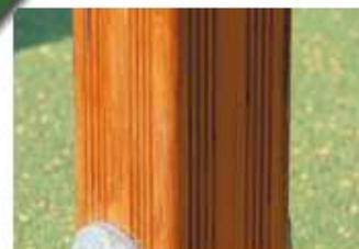
**Postes estructurales:** de pino laminado-pegado tratado clase IV, acabados con o sin lijado y barniz, aislados del contacto con el suelo por una estructura de cimentación en acero galvanizado. Protección de las caras superiores expuestas a la intemperie con acabados especiales de poliamida.
